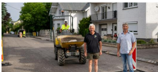
Ortsvorsteher Werner Huber und Bgm. Ing. Johann Zimmermann auf der Baustelle.
